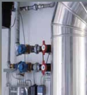
Ótima válvula para todas as aplicações, a válvula solenoide EV250B é a escolha preferencial para muitos fabricantes em aplicações com baixas pressões diferenciais, tais como sistemas de aquecimento. Seu design não apenas permite uma ampla faixa de pressão, mas também reduz o ruído e aumenta a vida útil do sistema ao evitar golpe de aríete.
