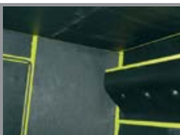
Material de atenuación de ruido ignífugo
