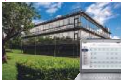
Sistema de gestão de edifícios (BMS)
