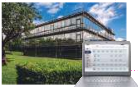
Sistema de gestão de edifícios (BMS)
