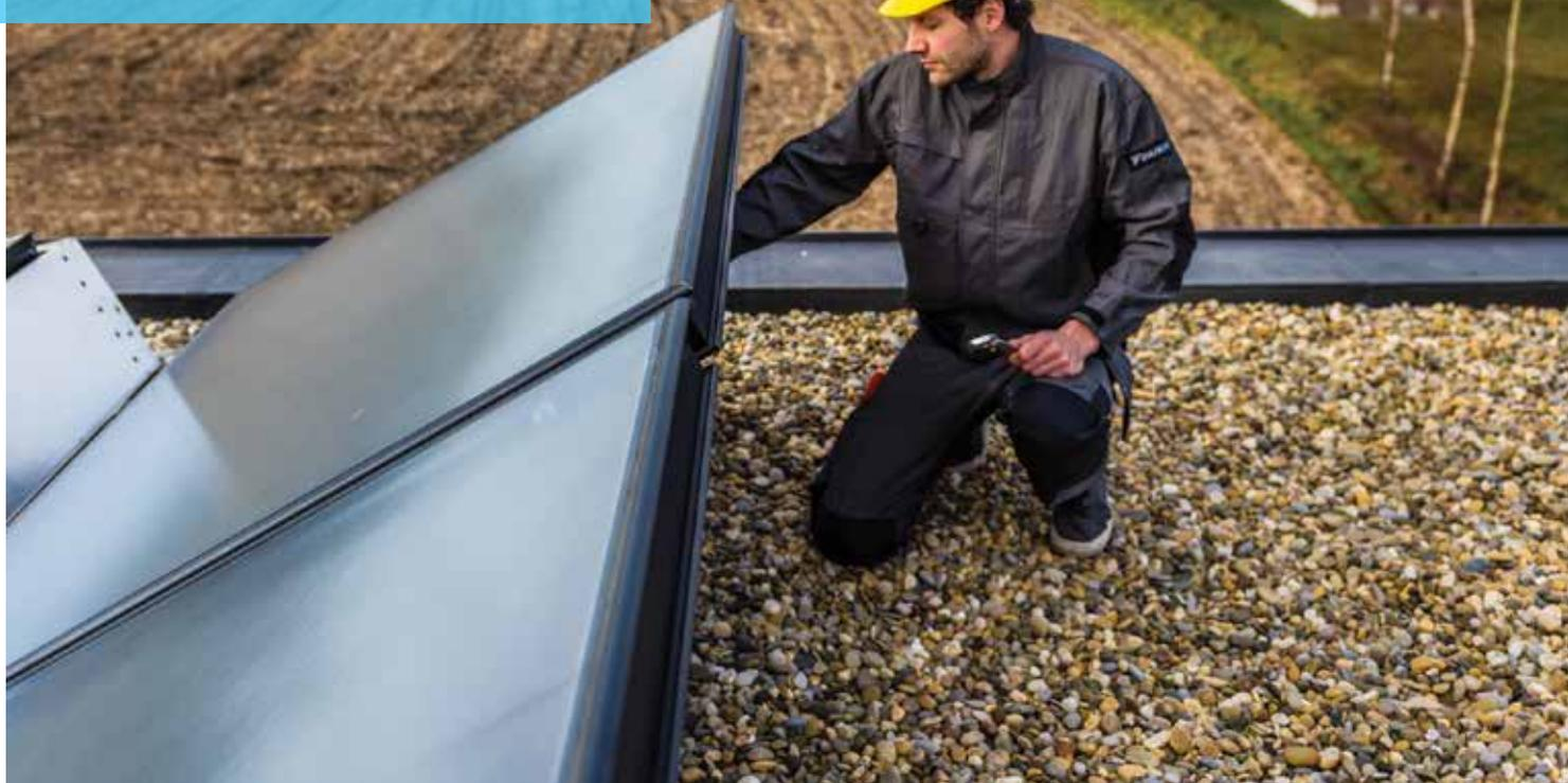
As soluções solares da Daikin maximizam o uso da energia renovável gratuita da radiação solar, por meio de coletores solar planos de alta eficiência. A Daikin dispõe de duas soluções para aproveitamento solar térmico, o sistema mais comum pressurizado e o sistema Drain-Back.
