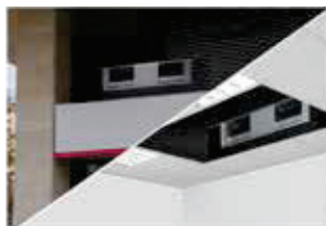
Módulo permutador de calor
