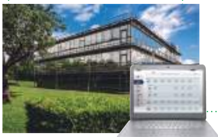
Sistema de gestão de edifícios (BMS)
