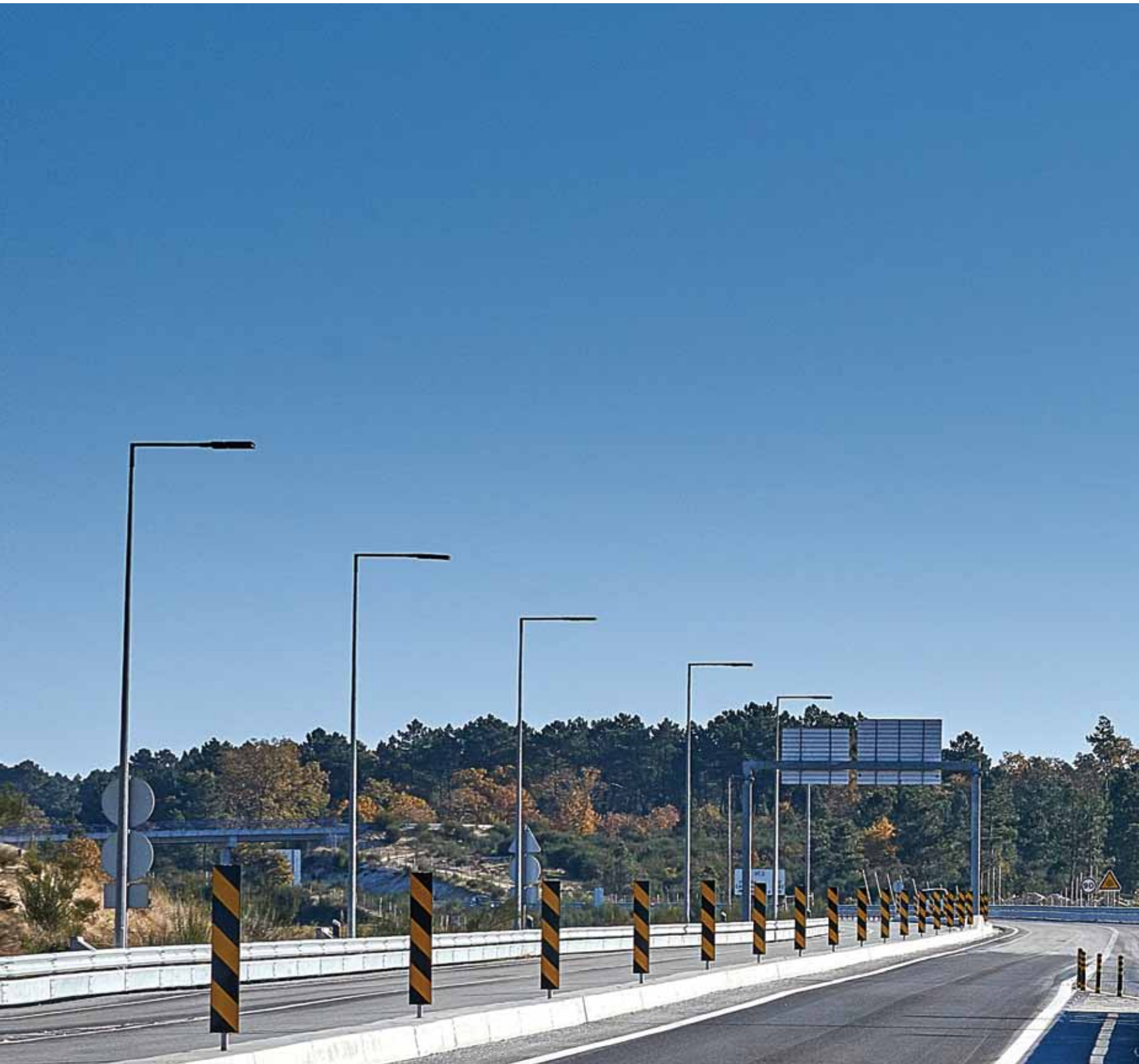
Concessão Douro Interior, IC5 - Carrazeda de Ansiães
