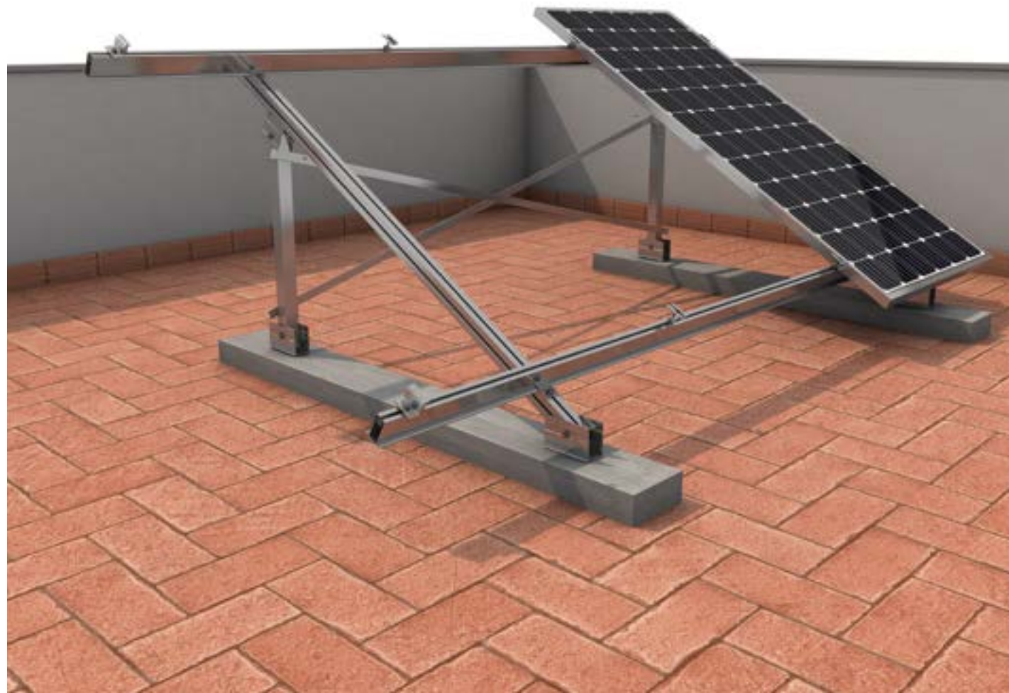
Instalación correcta de triángulo abierto sobre contrapesos de hormigón.
