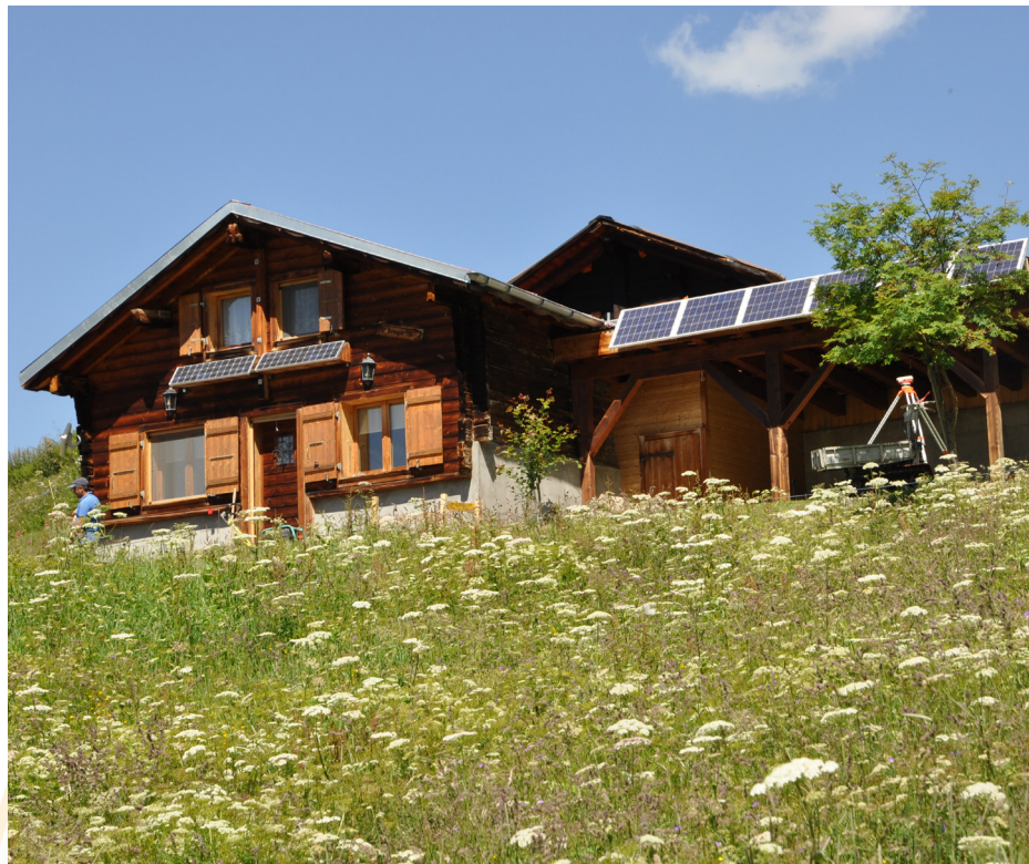
Instalación aislada, Suiza, AJ 2400-24-S
