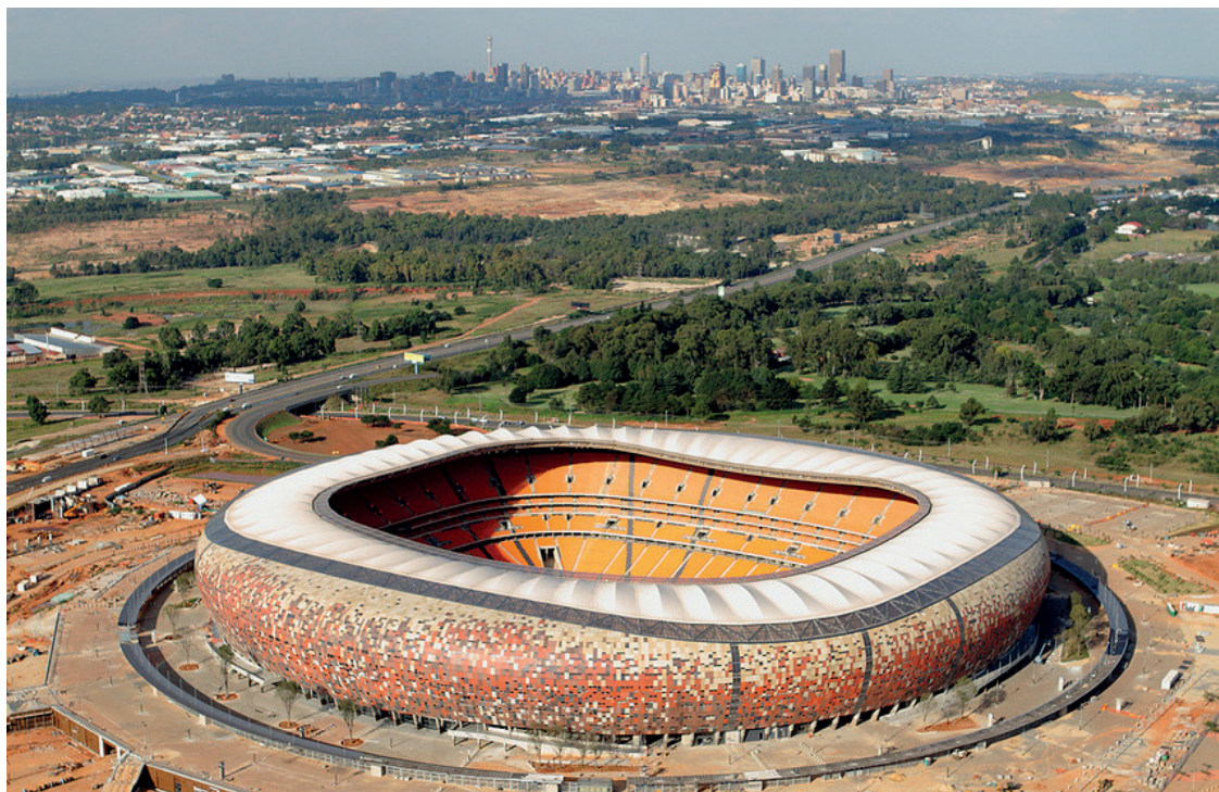
Instalación SAI, Johannesburgo, 6 x XTH 6000-48
